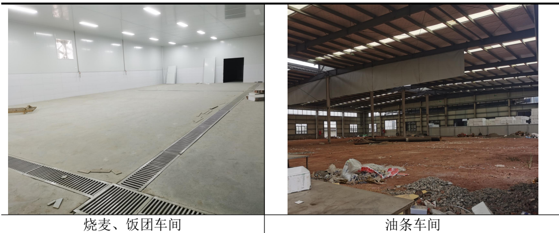
图 2-11 项目现场情况
